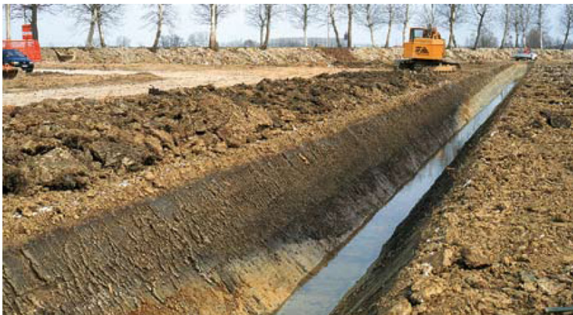
Figura 11. Sezione di un paleoalveo rinvenuto durante i lavori per l'idrovora di Loncon nella tenuta Bosco del Merlo 15 , come si può notare, gli argini sono quasi assenti
